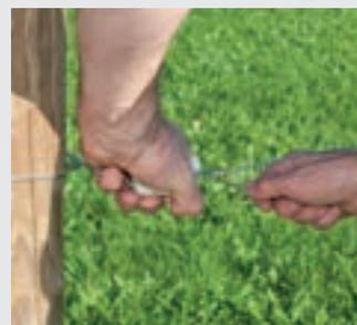
7. Loses Drahtende 5-mal um den Zaundraht wickeln
