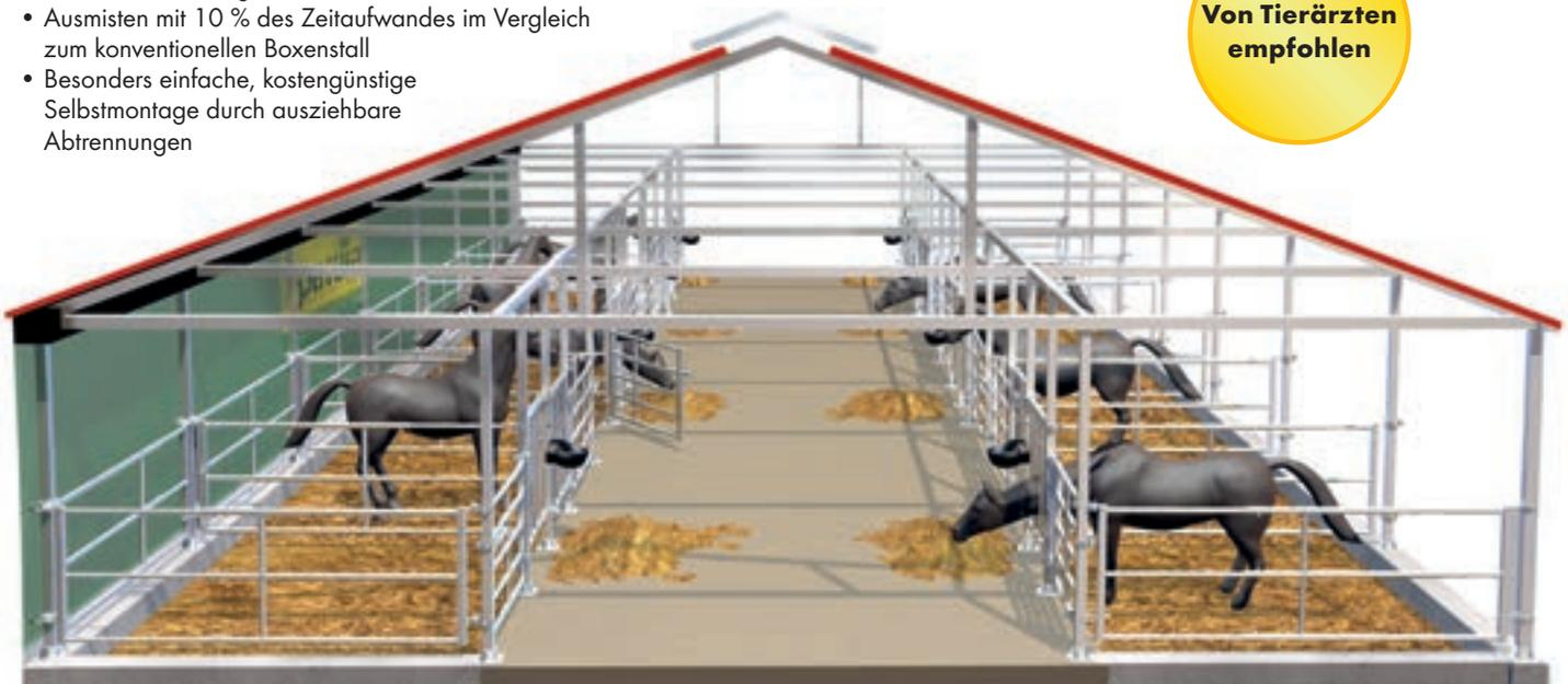
Hohe Luftvolumina und ein offener First sorgen für schnellen Abtransport aller Schadgase im Stall; Windschutznetze in Hauptwindrichtung angeordnet verhindern Zugluft im Stall
