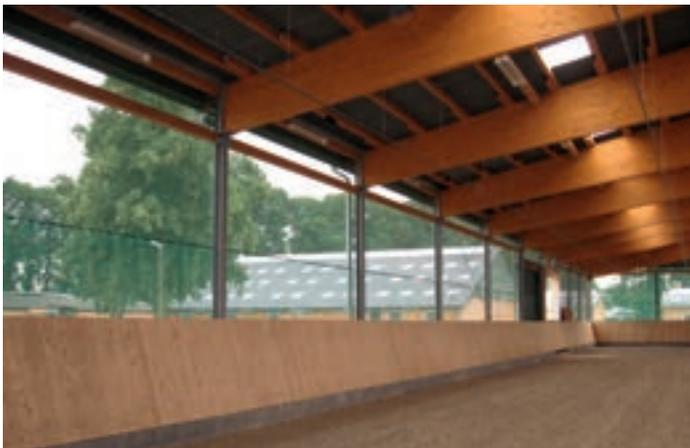
Mit Alu-Profilen fest installierte Windschutznetze für optimale Gebäudebelüftung und Helligkeit im Stall
