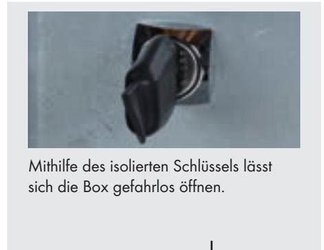
Mithilfe des isolierten Schlüssels lässt sich die Box gefahrlos öffnen.
