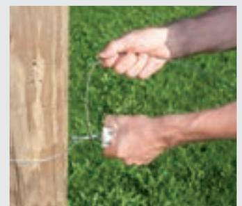
4. Ende 5-mal um den Zugdraht wickeln
