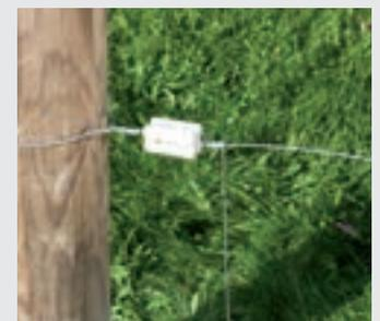
8. Drahtende lang lassen zur Querverbindung
