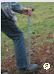
2 Eckpfähle an allen Ecken und Kurven setzen
